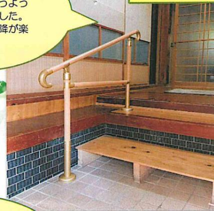
O様宅は玄関土間から居間への上り框が高く、脇の三段ボックスにつかまって昇降され危険でした。高さの合う踏み台と手すりを設置し安全になり喜ばれています。
