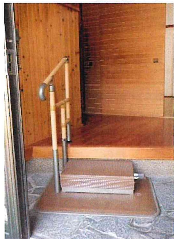
(玄関 ご本人の動線を考え手すりは片側のみ利用)
