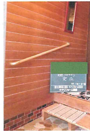
玄関・勝手口 手すり取付事例 (介護保険住宅改修)
